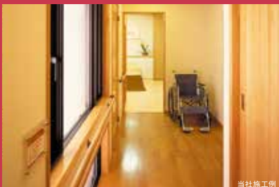
手すりの取り付け
