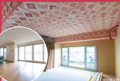
室内の断熱(断熱ボード)
