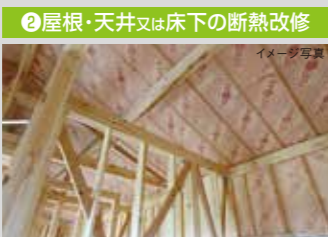
②屋根・天井又は床下の断熱改修
