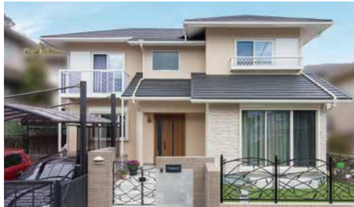
瓦屋根〈葺き替え〉
